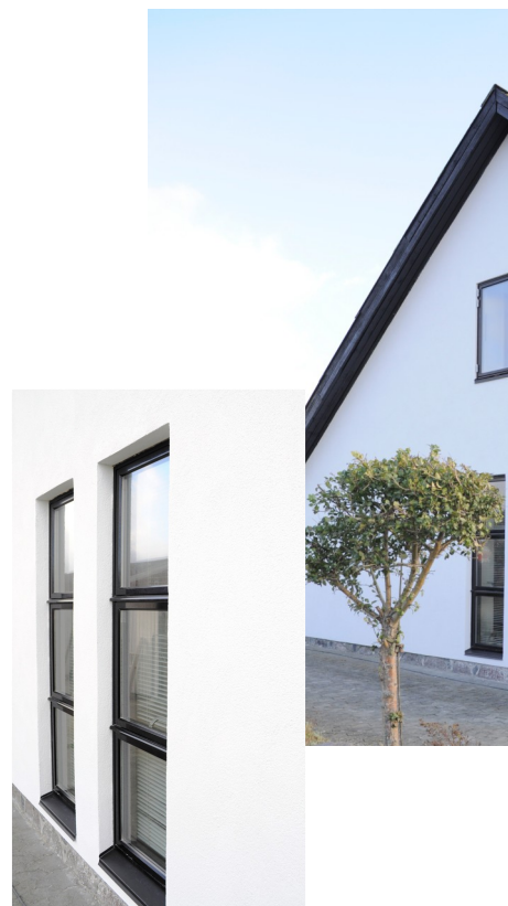
Færdig facade Hasseløvej 81, Hasselø Foto: Troels Jørgensen A/S
